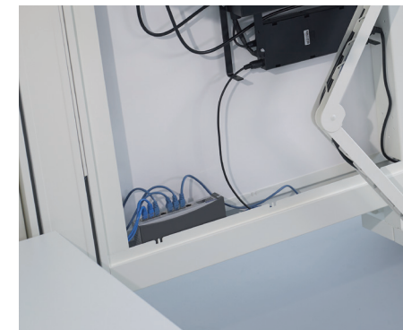
Router geplaatst in systeemwand
