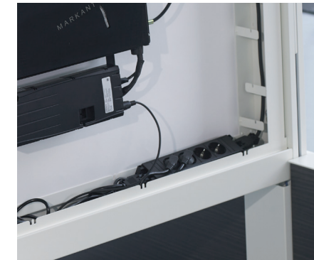
Stekkerblok in systeemwand
