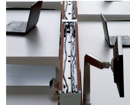
Bekabeling door Centrale kabelgoot
